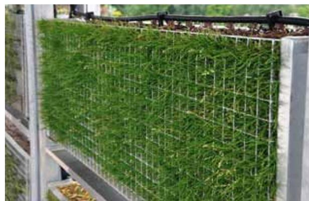
Vue de détail d'un module de bac grillagé «VG-Biobed» planté de gazon avec le système goutte-à-goutte qui alimente les végétaux avec les effluents.
