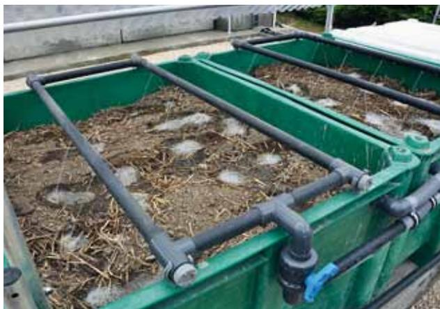
Le système de Biobed «Biobac® PEHD / Biotisa» dont le substrat doit être régulièrement enrichi de paille (apport de matière organique nécessaire aux microorganismes du sol).
