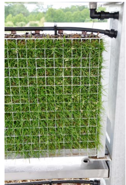
Ansicht eines Moduls des "VG-Biobed" Systems, wo das überschüssige Abwasser aufgefangen wird und wieder in das unterirdische Auffangbecken gelangt, von wo aus es wiederum auf die Pflanzen getropft wird.
