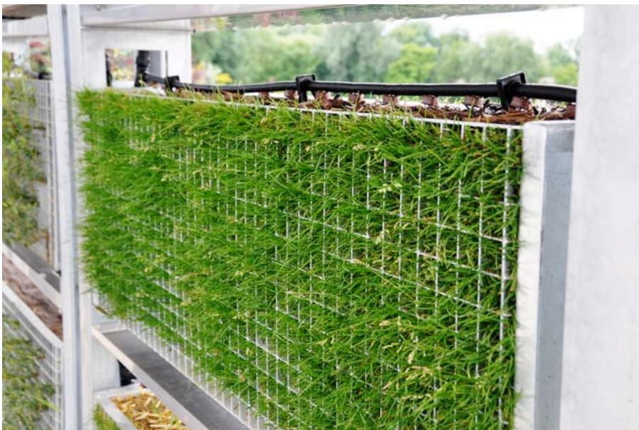
Detailansicht eines Siebschalen-Moduls "VG-Biobed", begrünt mit Rasen und mit dem System, das die Pflanzen tropfenweise mit dem Abwasser versorgt.
