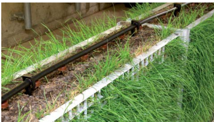
Das System «VG-Biobed™» verbraucht im Gegensatz zu anderen Aufbereitungsanlagen keine Erde, sondern produziert Biomasse, ist platzsparend, und kann zur Isolation von Gebäuden beitragen.
